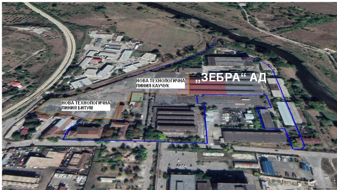
Фигура П.2-1 Сателитно изображение на „Зебра“ АД и местоположение на новата технологична линия
